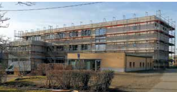
Am 20. Dezember 2020, kurz vor Weihnachten, ist der Rohbau geschafft
